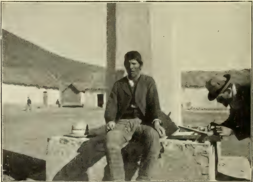
Fig. 145. — Installation en plein air à Urmiri.
